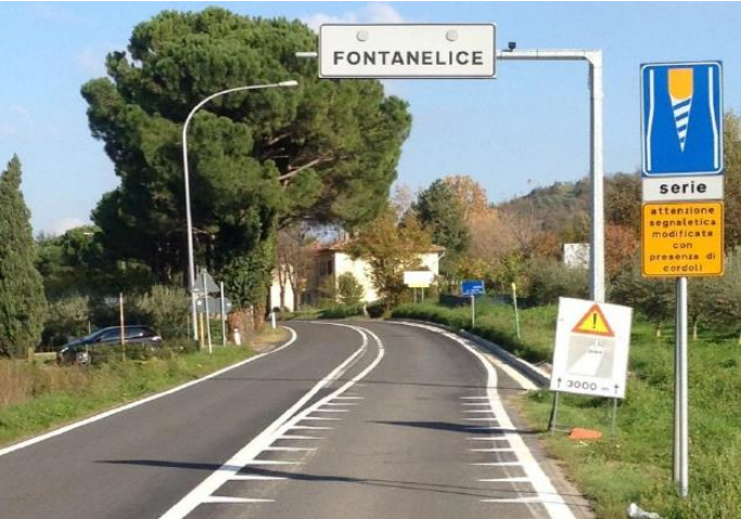
Figura 55: Esempio di portale a bandiera
