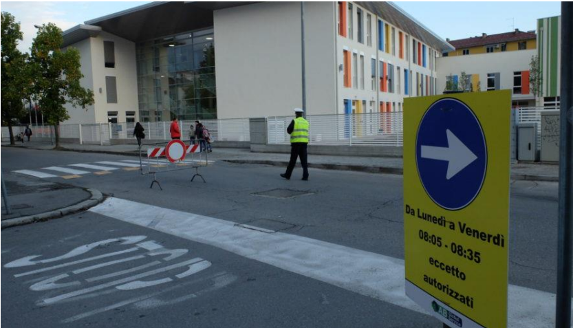
Figura 59: Chiusura al traffico veicolare
